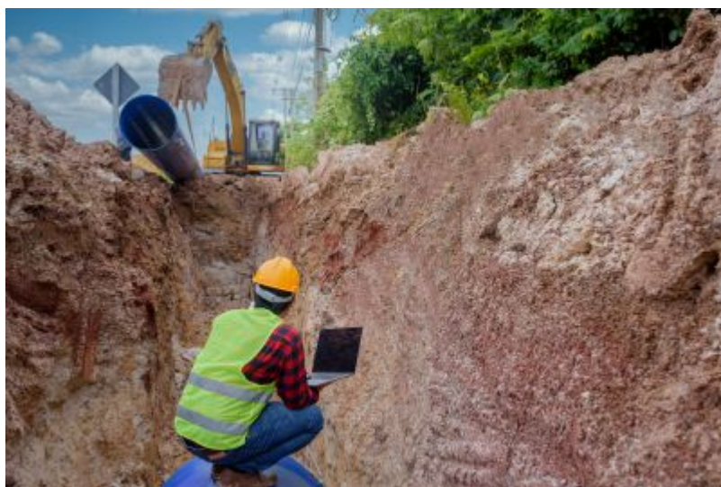
Budowa wodociągu i kanalizacji
