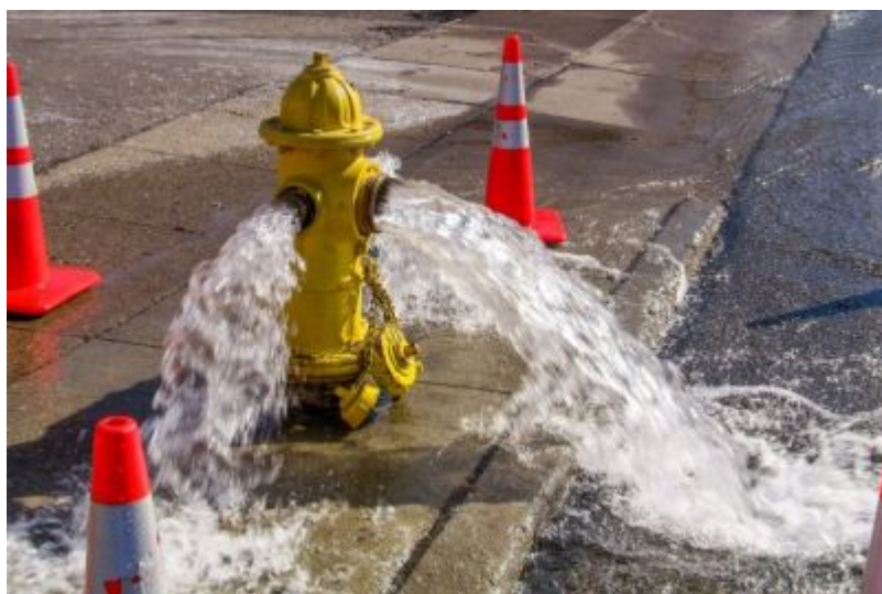
Płukanie sieci wodociągowej
